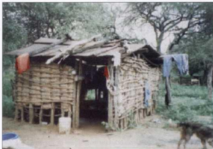
Fig. 4. Vivienda del Grupo I.
