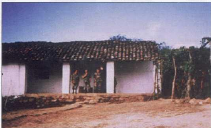
Fig. 8. Barracón (Alto Camiri) después del tratamiento.
